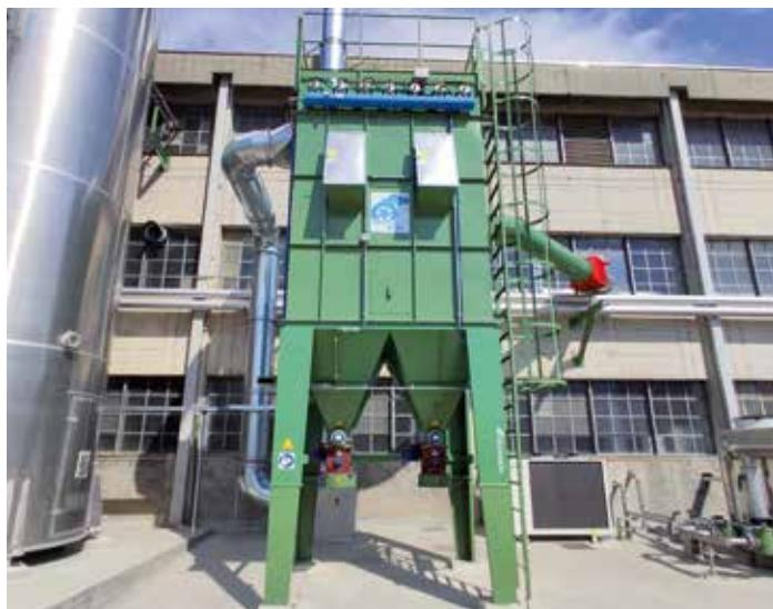
Utilizzati per il trattamento di polveri fini e ultrafini. Garantiscono efficienze di filtrazione molto elevate e possono essere realizzati in versione ATEX per atmosfere potenzialmente esplosive o in versione biomassa per processi di combustione.
