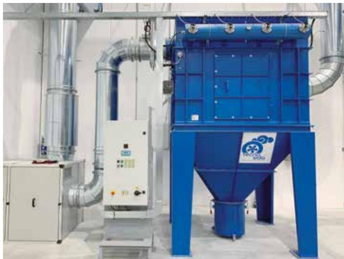
Utilizzati per il trattamento di polveri fini e ultrafini. Garantiscono efficienze di filtrazione molto elevate e possono essere realizzati in versione ATEX per atmosfere potenzialmente esplosive.
