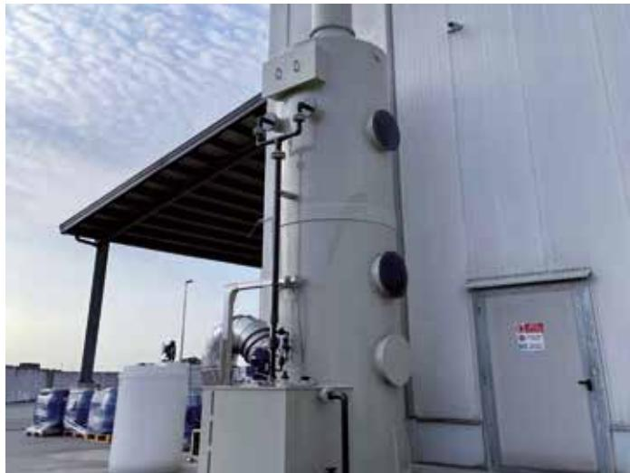
Tecnologia di abbattimento ad umido in cui gli inquinanti presenti nel flusso aeriforme vengono rimossi grazie all'utilizzo di un liquido di lavaggio a base di acqua. Gli scrubbers sono particolarmente indicati per l'abbattimento di COV (Composti Organici Volatili) e CIV (Composti Inorganici Volatili)
