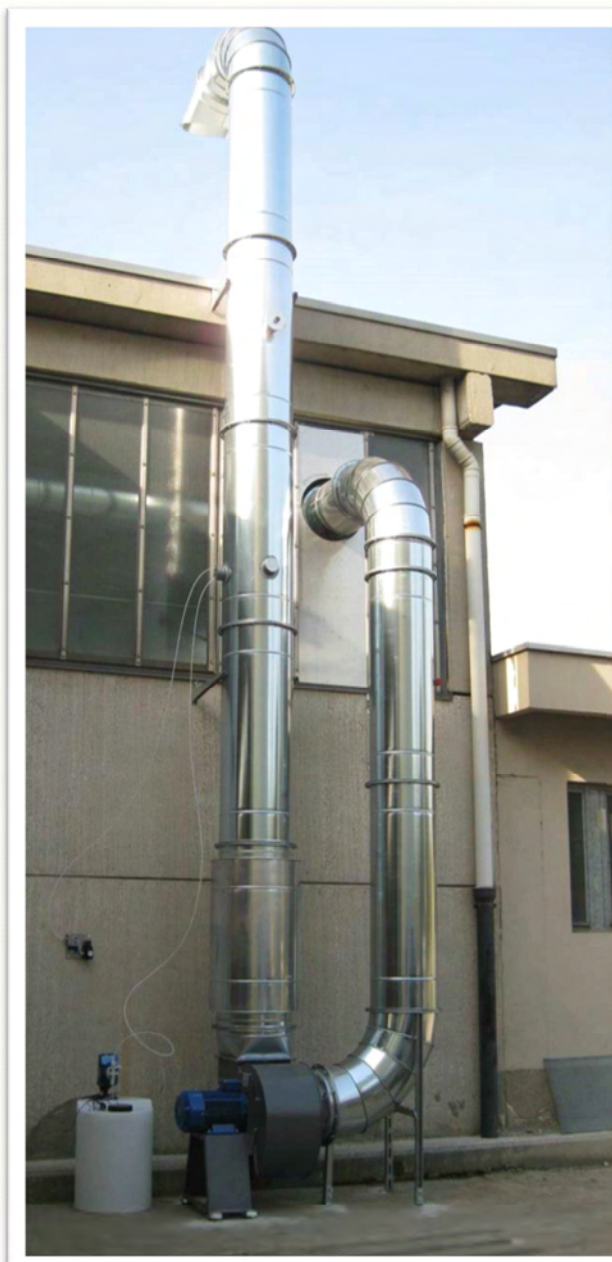
Il tino di contenimento prodotto deodorizzante da diluire con acqua in base alle concentrazioni di odori.
