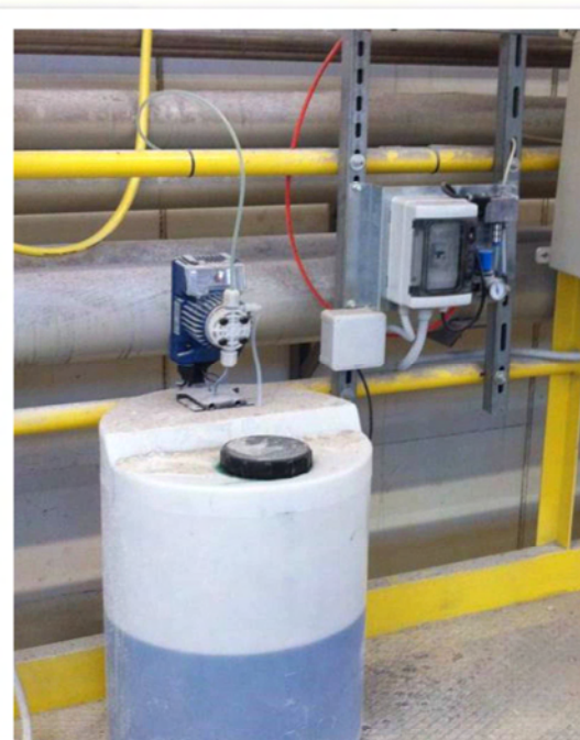
Il tino di contenimento prodotto deodorizzante da diluire con acqua in base alle concentrazioni di odori.
